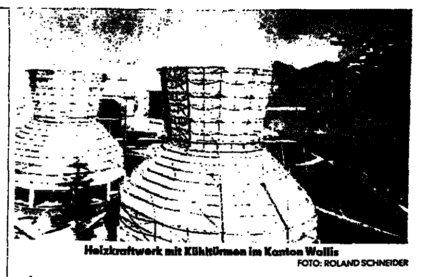
Heizkraftwerk mit Kühltürmen im Kanton Wollis. FOTO: ROLAND SCHNEIDER
